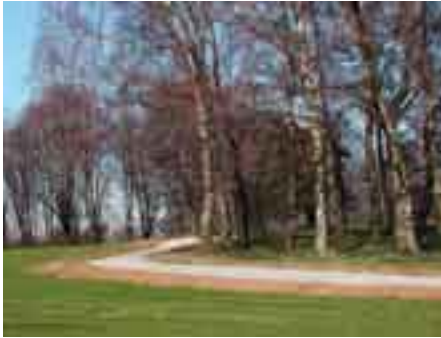
Bau eines Wirtschaftsweges über die Bahnen 1, 9 und 8, um auch bei widrigen Bodenverhältnissen mit Greenkeepingmaschinen den gesamten Ostplatz erreichen zu können.
