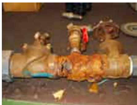
Erneuerte Verbindungsstücke bei der Beregnungsanlage Westplatz, hier alt ...
