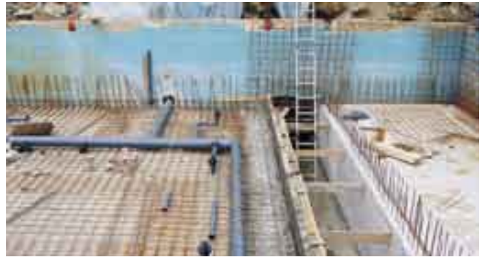
Schacht für die Schwimmbadabdeckung
