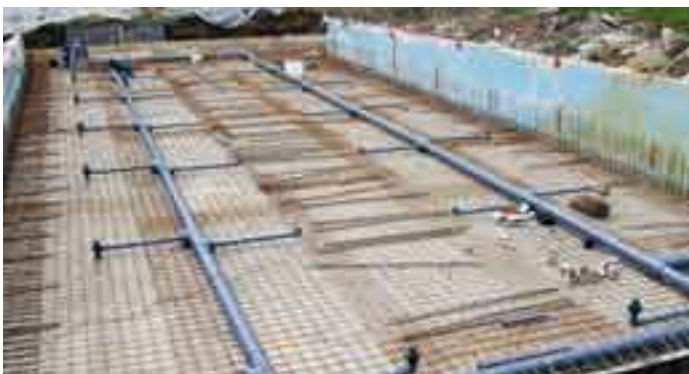
Rohrverlegung unter der zu betonierenden Bodenplatte
