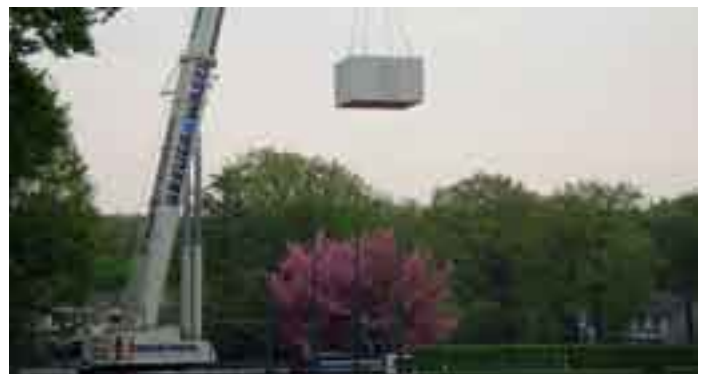
Anlieferung des Filterhauses
