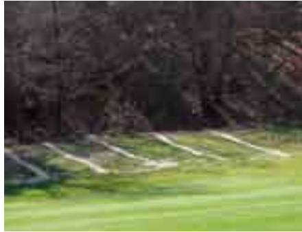
Offenlegung und Bau von Drainagen an den Bahnen 1, 12 und 18 des Ostplatzes.
