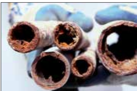
Wenn Kalkablagerungen und Rost die Rohre fest im "Griff" haben, kann die Luft-Wasser-Spülung hier helfen.
