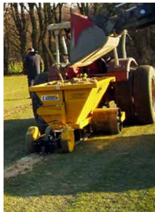
Verfüllung der Schlitzdrainagen mit Sand
