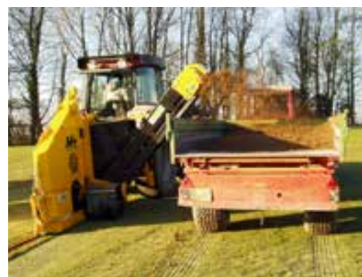
Herstellung der Schlitzdrainagen
