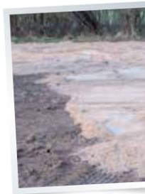
Auftrag der Sandschicht auf den abgeschälten Oberboden
