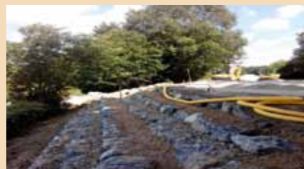
Trockenmauer in getreppter Ausführung während der Bauphase
